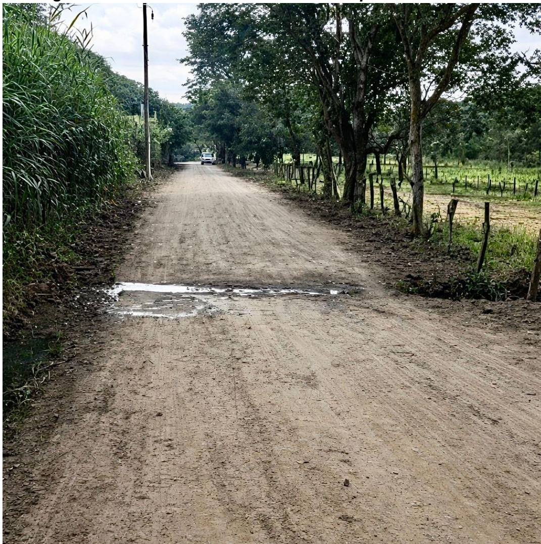
15.1 Figura 9: Vista frontal del tramo Jicaro-Empalme La Mia.
