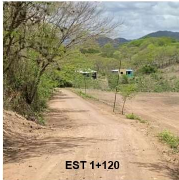
Figura 25 Estado actual del tramo EST 1+120
