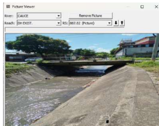
Figura 27 Puente Portezuelo en estación de cauce 0+887.82
