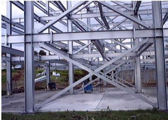
Ilustración 10 Arriostre lateral
