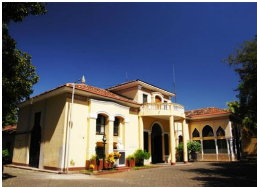
Figura 5.1. Instalaciones de la Empresa E.Chamorro Industrial, S.A, en la Ciudad de Granada
