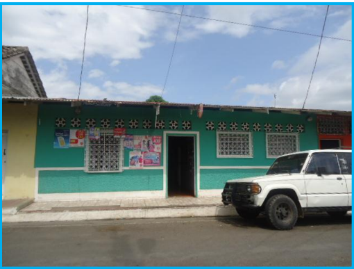
Ilustración 37 Vivienda de bloque, Fuente: Equipo M-IO 2014
