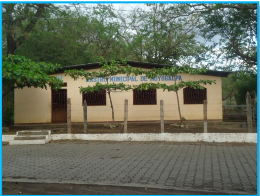
Ilustración 49 Ratro ubicado en Moyogalpa, Fuente: Equipo M-IO 2014
