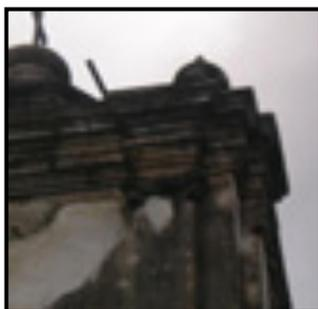
**Cornisa:** Parte superior y más saliente de una edificación. Tiene como función principal evitar que el agua de lluvia incida directamente sobre el muro o se deslice por el mismo, además de rematar el edificio. En la arquitectura clásica forma parte del entablamento, y está compuesta de varias molduras.
