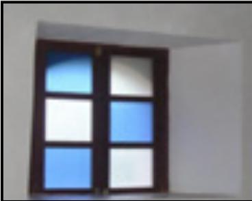
**Abocinamiento:** Técnica de construcción que consiste en hacer derrames del vano o puerta, ensanchándose hacia el lado interior o exterior mediante una disposición oblicua de las paredes con respecto al muro para lograr mayor iluminación.
