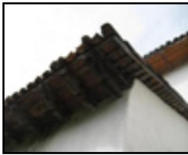
**Alero:** Parte de la cubierta de un edificio que sobresale de los muros exteriores. *Se llama corrido cuando es prolongación de la vertiente del tejado, de chaperón cuando no se apoya en canecillo y de mesilla cuando corre horizontalmente, formando cornisa.* (Glosario Ilustrado de Arquitectura, Arquitecto Eduardo Rodríguez, UNI-FARQ)
