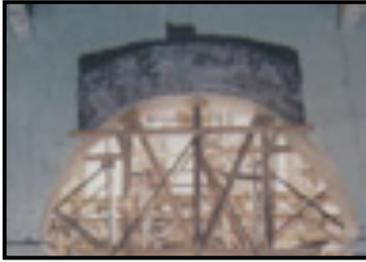
**Arco Toral:** Es un elemento arquitectónico, en concreto es el arco transversal a la nave que sustenta la bóveda. En las bóvedas de cañón es puramente un refuerzo.
