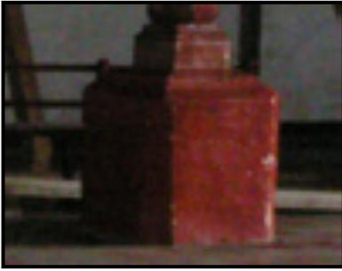
**Basa:** Parte inferior de la columna, que tiene como fin servir de punto de apoyo al fuste, está compuesto por molduras. En la ilustración se muestra la basa octogonal de una columna del Templo Santa María Magdalena de Totogalpa.
