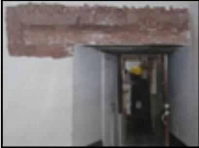
**Dintel:** elemento estructural horizontal que salva un espacio libre entre dos apoyos. Es el elemento superior que permite abrir huecos en los muros para conformar puertas, ventanas o pórticos
