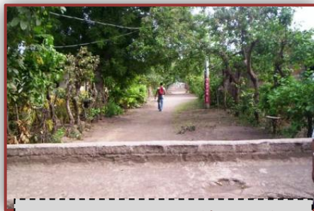
Foto No.9: Barrera construida para evitar el paso del agua pluvial, barrio La Mora. FI: Levantamiento de campo. 2009
