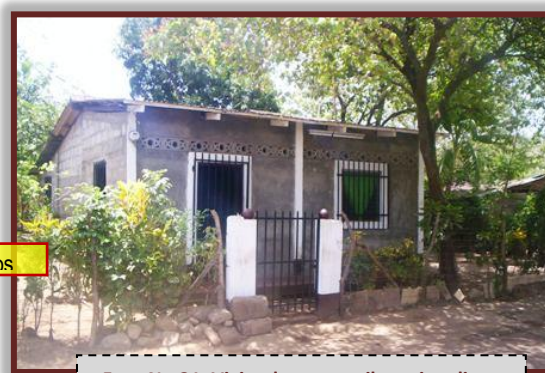
Foto No.31: Viviendas con estilo racionalista. FI: Levantamiento de campo. 2009
