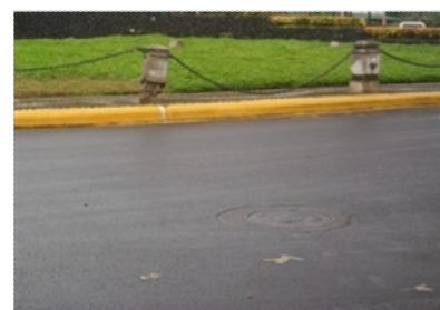
Foto 14 Sistema de alcantarillado sanitario pozos de visita Fuente: ENACAL Ing. Luigi José Navas
