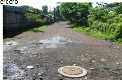
Foto 13 Sistema de alcantarillado sanitario pozos de visita Fuente: ENACAL Ing. Luigi José Navas
