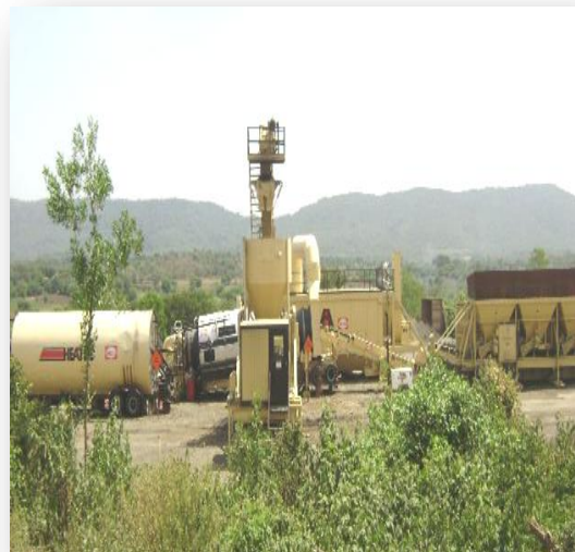
Foto No.14 Planta de asfalto
