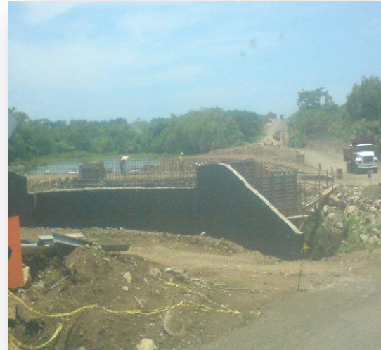
Foto No.2 Construcción de puente
