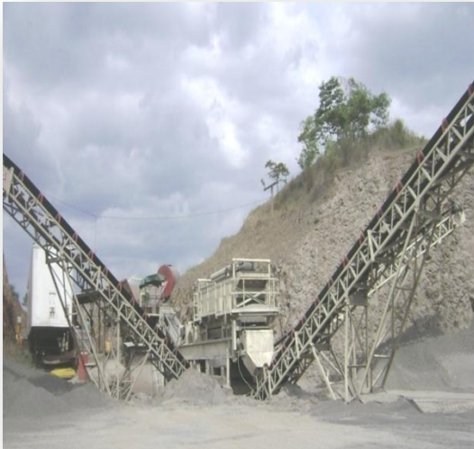
Foto No.5 Planta de trituración
