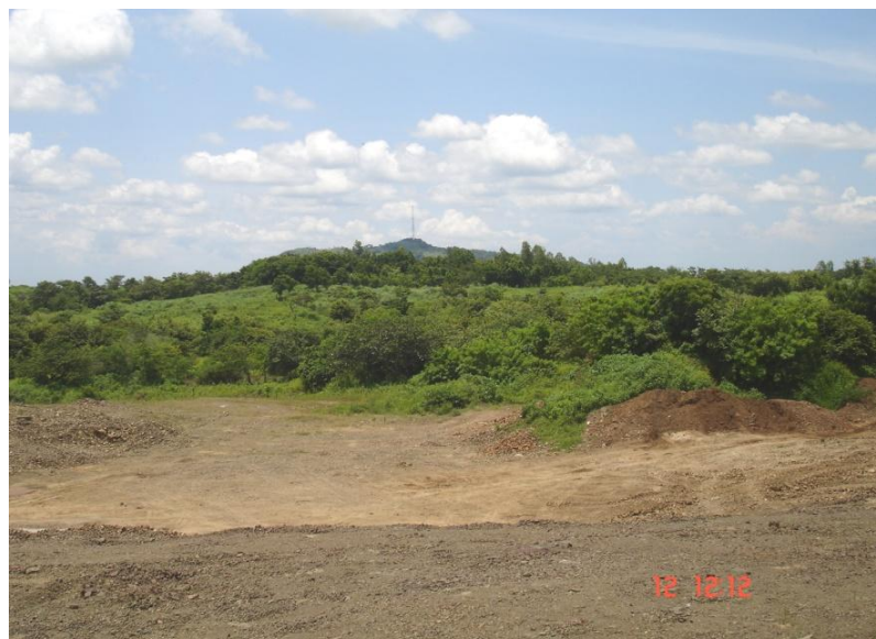
Figura No.9 Terreno del banco de materiales.
