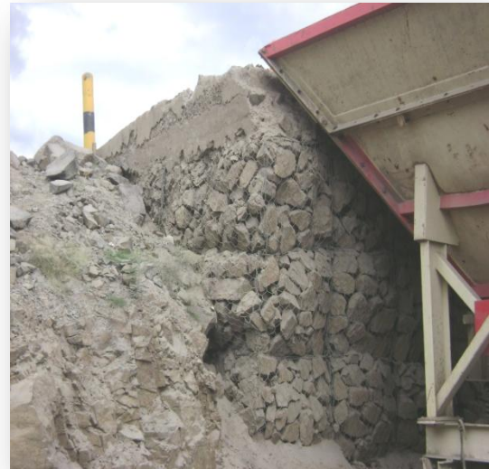
Foto No.6 Muros de contención
