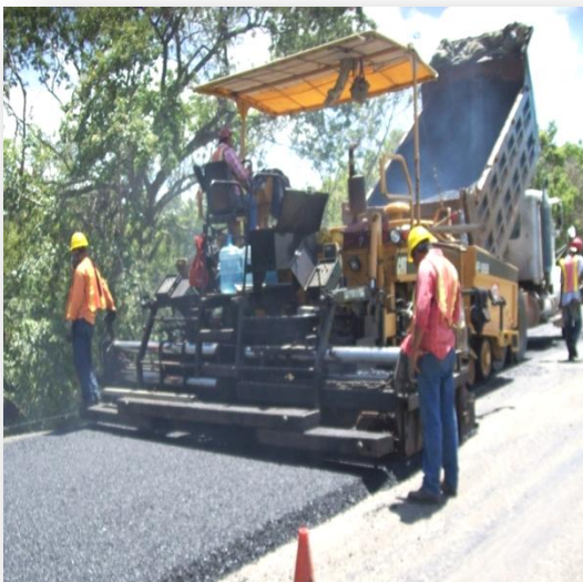
Foto No.3 Carpeteo de mezcla asfáltica
