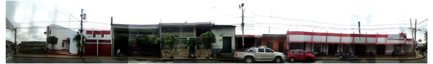
ILUSTRACIÓN 111. LEVANTAMIENTO FOTOGRAFICO MANZANA 04. EN ESTA PUEDE VERSE TAMBIÉN LA CORRESPONDENCIA DE ALTURAS ENTRE EDIFICACIONES DE DOS PLANTAS ACTUALES Y UNA DE REFERENCIA COLONIAL.
