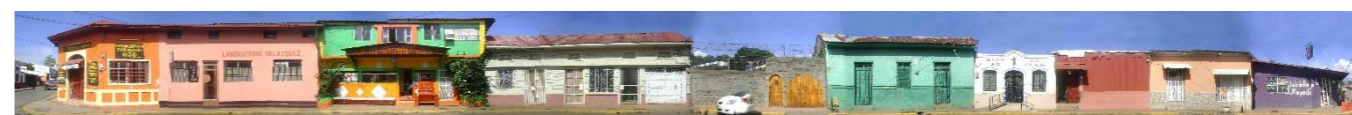
ILUSTRACIÓN 143. LEVANTAMIENTO FOTOGRÁFICO MANZANA 11. EN ROJO SE MARCA EL RITMO, VERDE LAS ARTICULACIONES. LAS FLECHAS CORRESPONDEN A LA ALTURAS ENTRE ALGUNAS EDIFICACIONES. FUENTE: EQUIPO DE TRABAJO.
