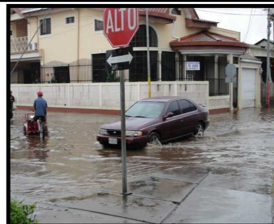
ILUSTRACIÓN 45. INUNDACIÓN DE LAS VÍAS LUEGO DE UNA LLUVIA. FUENTE: EQUIPO DE TRABAJO.
