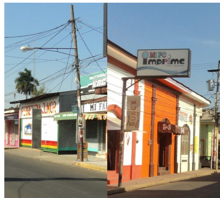
ILUSTRACIÓN 82. ALUMBRADO PÚBLICO, A LA MISMA VEZ QUE POSTE PARA EL TENDIDO ELÉCTRICO. EJEMPLO DE UN RÓTULO DE LOS EXISTENTES EN LA AVENIDA. FUENTE: EQUIPO DE TRABAJO.
