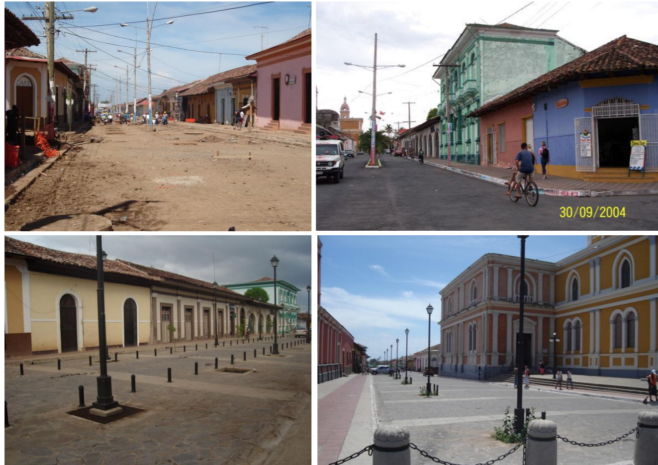
ILUSTRACIÓN 162. IMÁGENES DE LA INTERVENCIÓN REALIZADA EN LA CALLE LA CALZADA. DE IZQUIERDA A DERECHA: TRABAJOS DE REPLANTEO DE LA CALLE, DEL ÁREA DE RODAMIENTO, SITUACIÓN DE LA CALLE ANTES DE REALIZARSE LA INTERVENCIÓN, PUEDE VERSE EL BOULEVARD; MISMO BLOQUE DE MANZANA DE LA CALZADA YA INTERVENIDO, PUEDE VERSE LOS MATERIALES UTILIZADOS EN LA INTERVENCIÓN, MOBILIARIO URBANO; PARTE DE LA CALZADA CONTIGUO AL EDIFICIO CATEDRALICIO, ESPACIO PARA PLAZAS DE APARCAMIENTO. FUENTE: ARCHIVO OFICINA CENTRO HISTÓRICO GRANADA.
