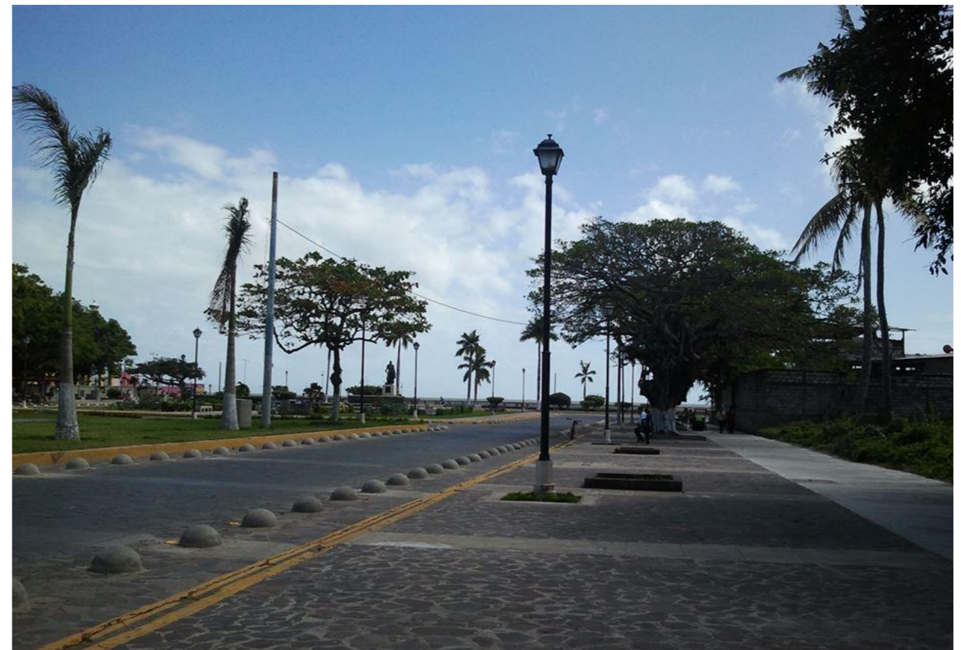
ILUSTRACIÓN 165. FOTOGRAFÍA DE PARTE DE LA INTERVENCIÓN REALIZADA EN EL SECTOR DE PLAZA ESPAÑA, PRÓXIMO AL MALECÓN DEL LAGO DE GRANADA, PARTE DE LA SEGUNDA INTERVENCIÓN Y ÚLTIMA DEL PROYECTO DE REVITALIZACIÓN DEL EJE, SE PUEDE OBSERVAR LA LIMPIEZA DEL ESPACIO Y EL RICO PAISAJISMO QUE FORTALECE ESTA ZONA. FUENTE: EQUIPO DE TRABAJO.
