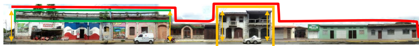
ILUSTRACIÓN 110. LEVANTAMIENTO FOTOGRAFICO DE LA MANZANA 03, EN COLOR ROJO SE MUESTRA EL RITMO ALTERNO, EN VERDE BALAUSTRADA COMO REMATE SUPERIOR, Y EN NARANJA DOS EDIFICACIONES NUEVAS QUE SE UNIFICAN CON LA ALTURA (FLECHAS NARANJAS) DEL INMUEBLE NEOCLÁSICO. FUENTE: EQUIPO DE TRABAJO.
