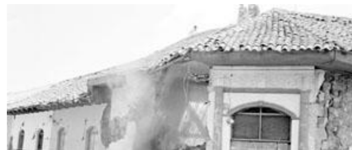
ILUSTRACIÓN 20. CASA CURIAL SAN JERÓNIMO DESTRUIDA POR EL TERREMOTO DEL AÑO 2000. FUENTE: ARCHIVO INETER.
