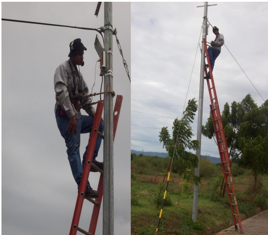
Instalación de cableado eléctrico.
