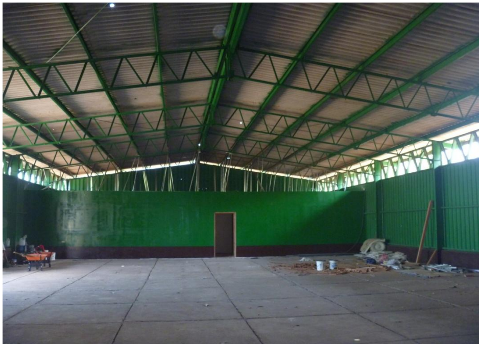
Estructura interna de Bodega con iluminación y ventilación natural.
