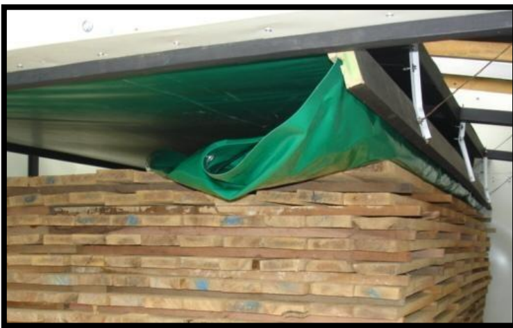
Figura 6.8: Detalle de instalación y ubicación del baffle
