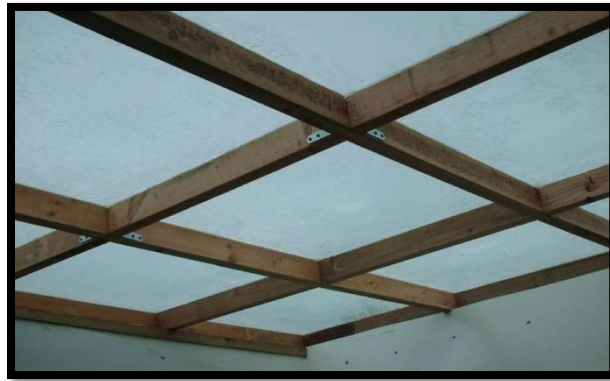
Figura 6: Vista inferior del techo instalado
