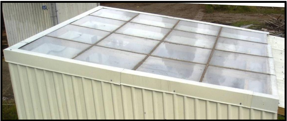
Figura 6.5: Vista superior del techo instalado
