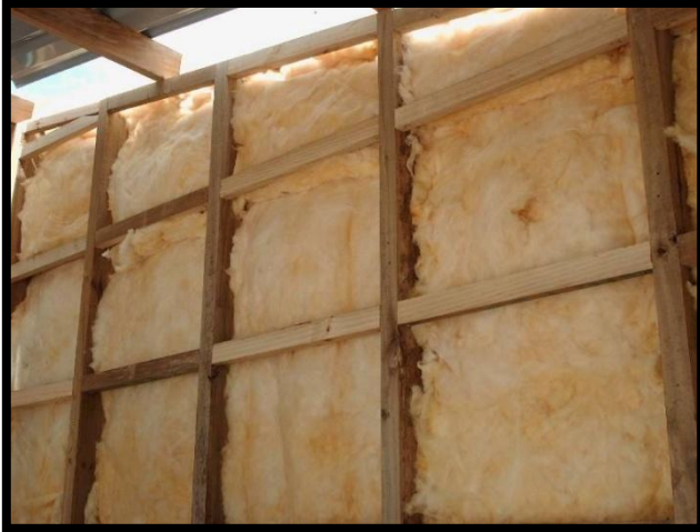
Figura 6.6: Instalación de fibra de vidrio
