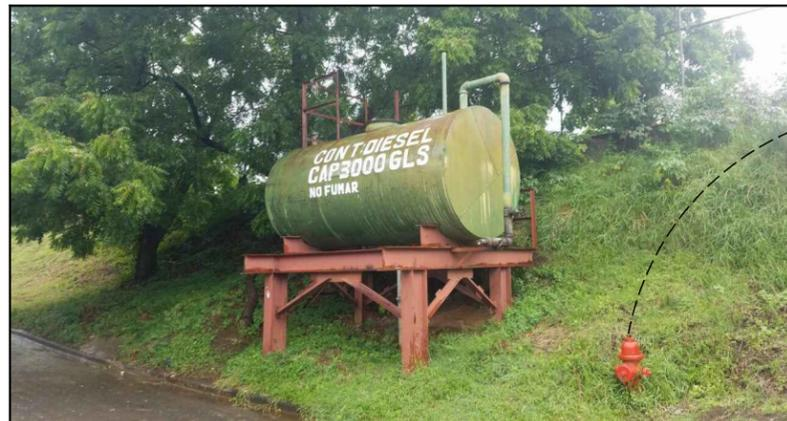
Foto # Tanque de almacenamiento metálico con capacidad de 3000 Galones de Diesel. Fuente: Fotografía tomada por Autores.
