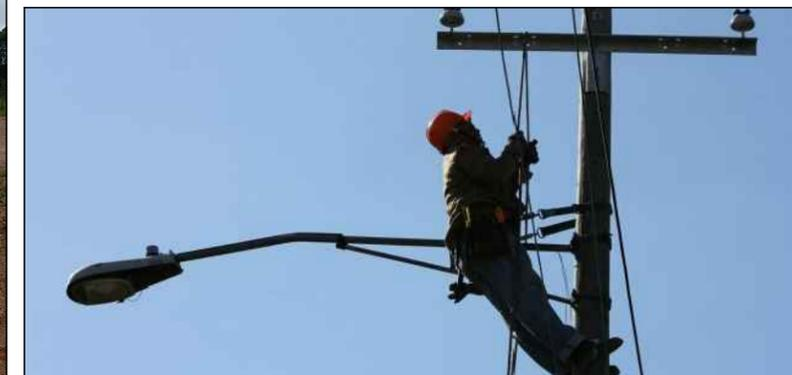
Personal de la Empresa ENEL, ejecutando mantenimiento a poste de tendido eléctrico
