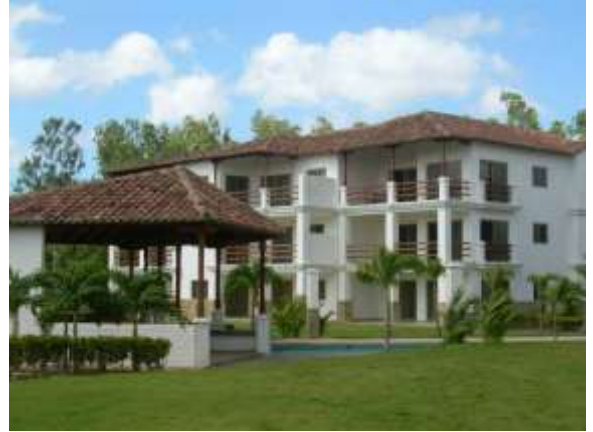
Imagen 13: Vista #2 Iguana Condos. Fuente: RC Arquitectos
