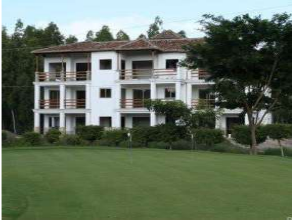
Imagen 12: Vista #1 Iguana Condos. Fuente: RC Arquitectos
