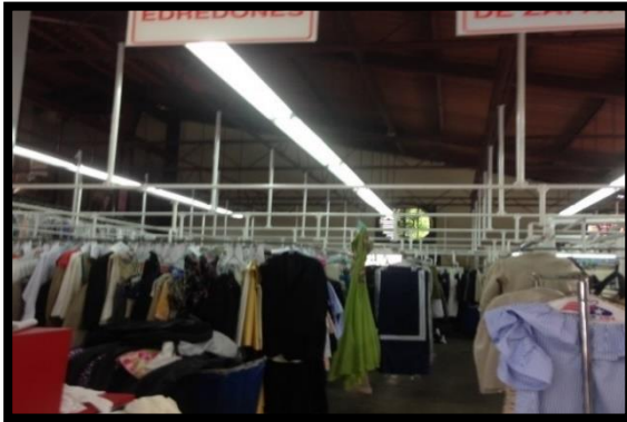
Imagen .2 y 3. Luminarios colgantes con lámparas fluorescentes T-12 de 75 W.
