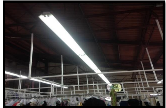
Imagen .2 y 3. Luminarios colgantes con lámparas fluorescentes T-12 de 75 W.
