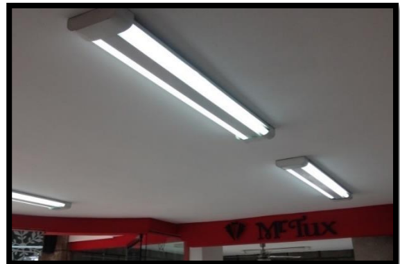
Imágenes 4 y 5 Luminarios empotrados, con lámparas fluorescentes T-12 de 40W
