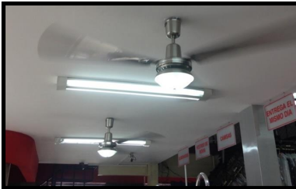
Imágenes 4 y 5 Luminarios empotrados, con lámparas fluorescentes T-12 de 40W
