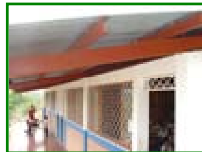
Vista externa de aulas, se aprecia la estructura de la cubierta
