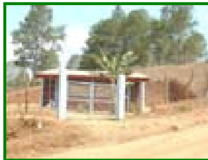
Vista panorámica de la escuela, se observa la topografía accidentada del terreno.
