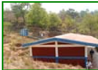
Vista panorámica de la escuela, se observa la topografía accidentada del terreno.
