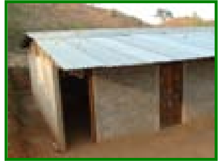
Vista exterior de agrupamiento 3.
