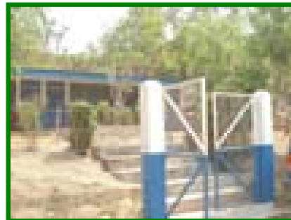
Vista de la fachada principal.
