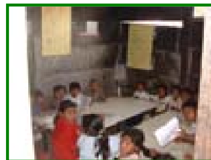
Vista interna de la escuela, la cual no presta las condiciones para recibir clase.
