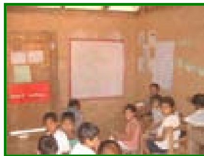
Vista interna de aula, se aprecia la falta de condiciones que tiene el local.
