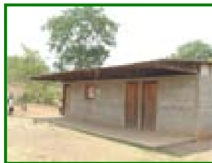
Vista externa de la escuela
