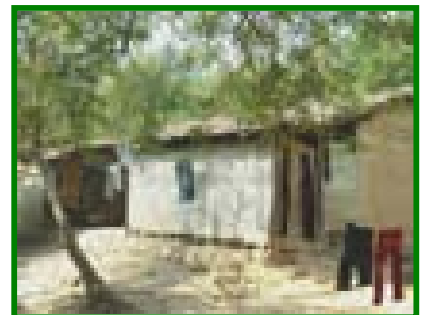
Vista del local donde funciona el Preescolar
