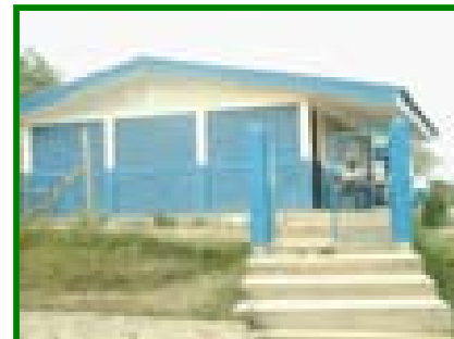
Vista del acceso del acceso principal.
