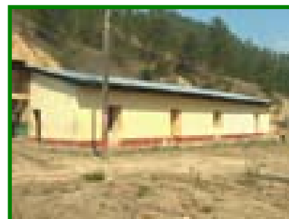
Vista del local donde funciona el Preescolar
