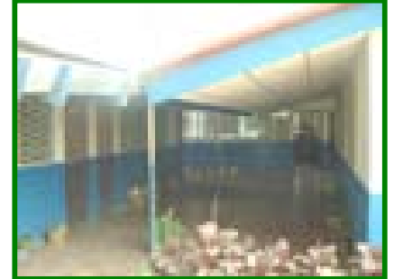
Vista del corredor interno de la escuela Naciones Unidas
