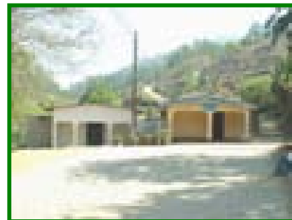
Vista de la fachada principal
