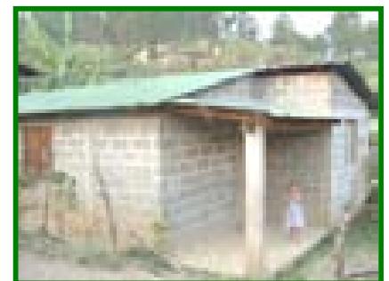
Vista del local donde funciona el Preescolar
