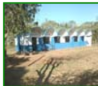
Vista del Agrupamiento 2 (aulas).
