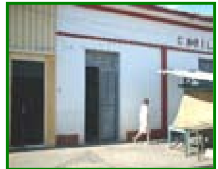
Vista del Acceso Principal al Preescolar.
