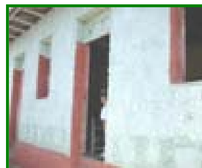
Vista del Acceso Principal al Preescolar.
