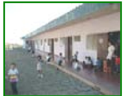
Vistas Panorámicas del Agrupamiento 2 (aulas).
