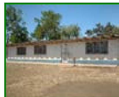
Vista Panorámica del Agrupamiento 1 (aulas)
