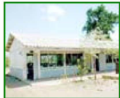
Vista Panorámica del Agrupamiento 3 (aulas).
