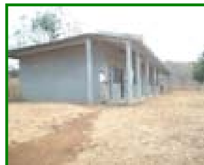
Vista del Acceso Principal al Centro Escolar
