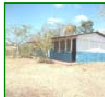
Vista Panorámica del Agrupamiento 1 (aulas)
