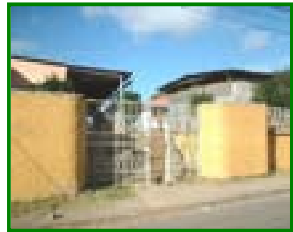
Vista del Acceso Principal al Centro Escolar.
