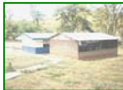
Vista panorámica del agrupamiento 1 y 2 (aulas)
