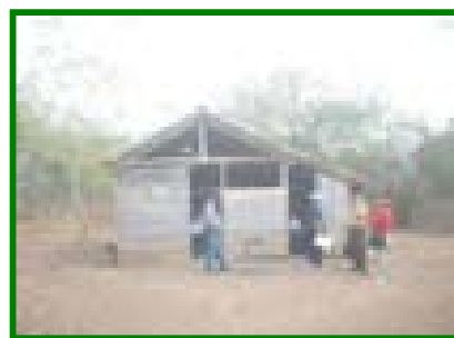
Vista panorámica del Agrupamiento 1(aulas)
