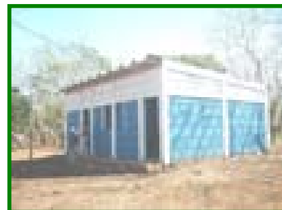
Vista panorámica del Agrupamiento 1 (aulas)
