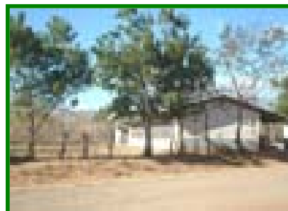
Vista panorámica del Agrupamiento 1 (aulas)
