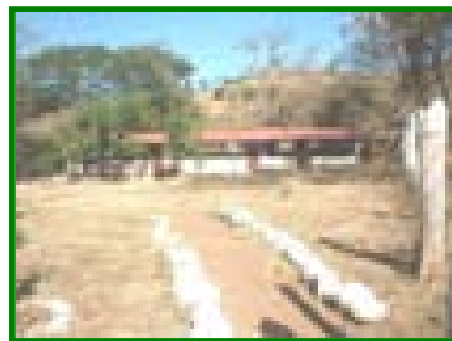
Vista panorámica del Agrupamiento 1 (aulas)
