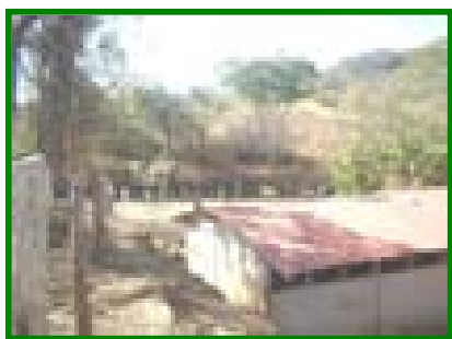
Vista lateral del Agrupamiento 1 (aulas)
