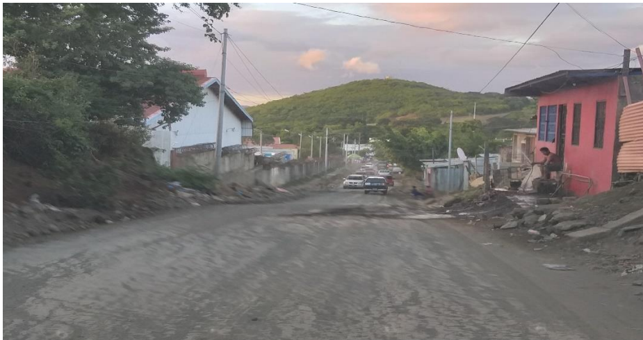
Figura 2. Tramo norte de carretera del proyecto
