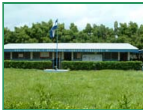
Vista de la fachada principal de un rebellón y el asta de bandera
