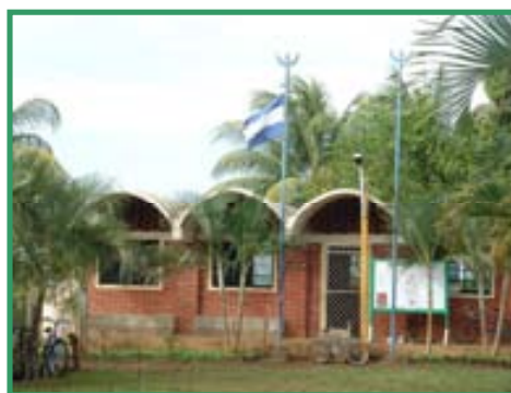
Fachada Principal del Agrupamiento 1
