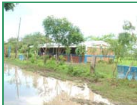
Vista panorámica de Escuela José Dolores Estrada
