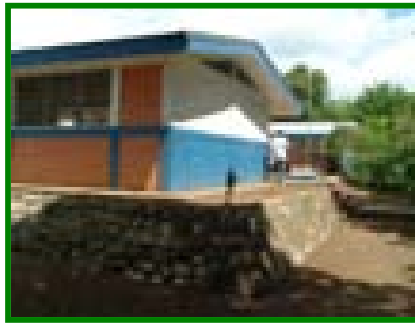
Vista parcial de los agrupamientos
