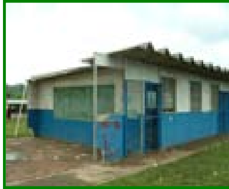
Vista parcial del Agrupamiento 2.
