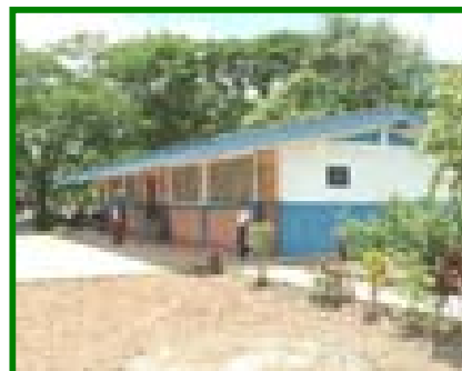
Vista parcial del Agrupamiento 1
