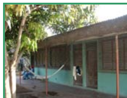
Vista del agrupamiento 2, con la única aula en uso (aula derecha). El resto de las aulas son ocupadas como vivienda.
