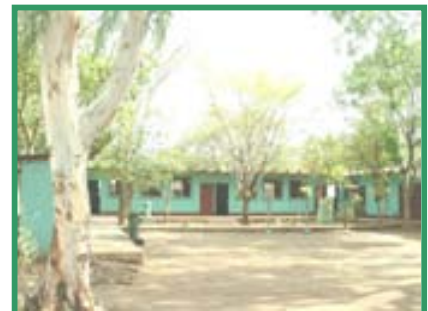
Vista del patio interno del instituto orientación Suroeste.
