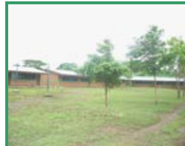
Vista Interna del centro con agrupamientos, sistemas constructivo de mampostería confinada y cerramiento de bloque con cubierta galvanizada.
