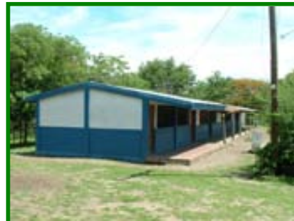
Vista de la Fachada del Agrupamiento 1, conformado por 4 aulas con adecuada orientación.
