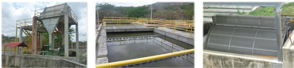
**Figura 1. Cribado + UASB + microfiltro, en PTAR Boaco**
