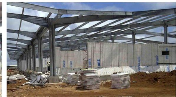
Foto No.30: Sistema constructivo de perfiles de acero del Aeropuerto Seymour
