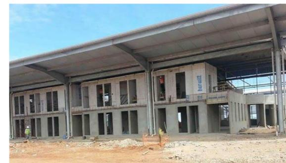
Foto No.30: Sistema Constructivo Avanzado Emmedue del Aeropuerto Seymour
