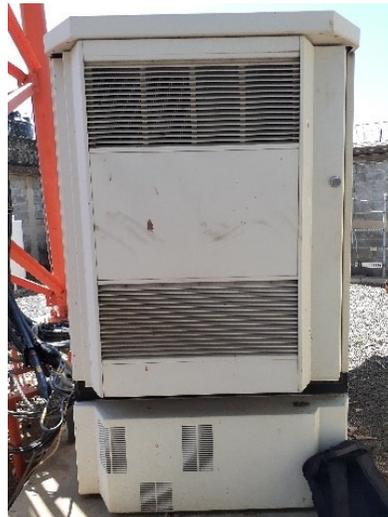
**Figura 20. Foto tomada de una caseta que contiene tecnología GSM.**
