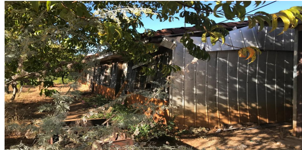
Imagen N°.5 edificio existente fuente EMI
