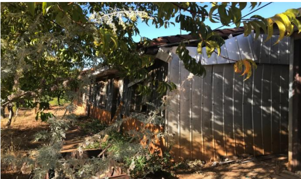
Imagen N°. 9 Edificio existente para reconstruir/ fuente: EMI
