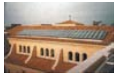
Captador sobre la cubierta
