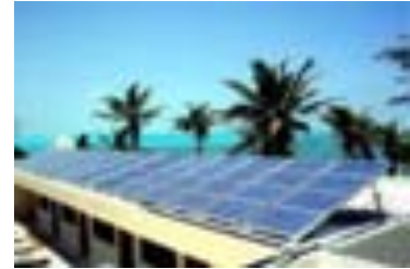
Colocación sobre cubierta plana
