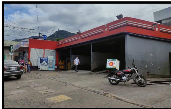
GAS CENTRAL: Área de Autolavado.
