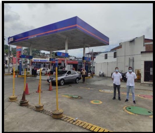
GAS CENTRAL: Área de pista y descargue de combustible.
