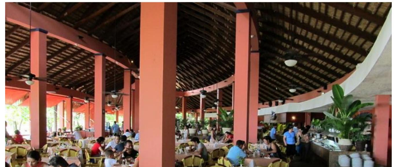
FOTO 71: estructura del bufete; techo de palma, vigas de madera y columnas de concreto armado.
