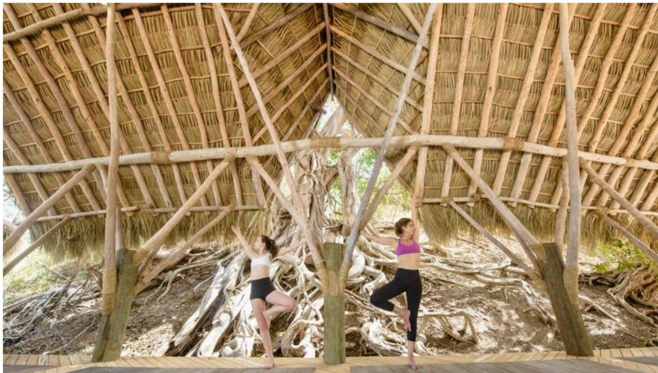
FOTO 59: sistema de columnas y vigas de madera con cubierta de palma en el área de yoga
