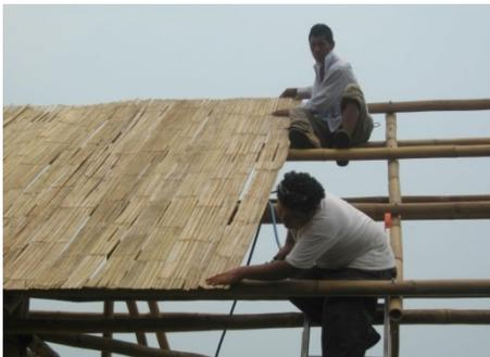
**IMAGEN 11: COLOCACIÓN DE CIELO FALSO DE ESTERILLA ANTES DE CUBIERTA**
