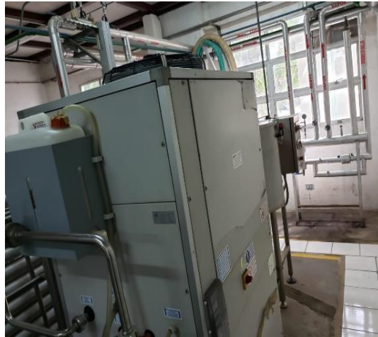
Ilustración 12. Unidad de refrigeración
