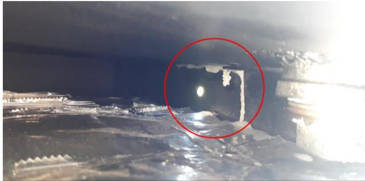
Figura E.2 Fuga de parafina vista por debajo del contenedor – absorbedor
