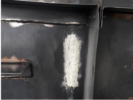
Figura E.7 Reparación colector solar zona de deflector
