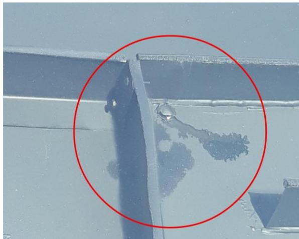
Figura E.3 Fuga de parafina en zona de soldadura
