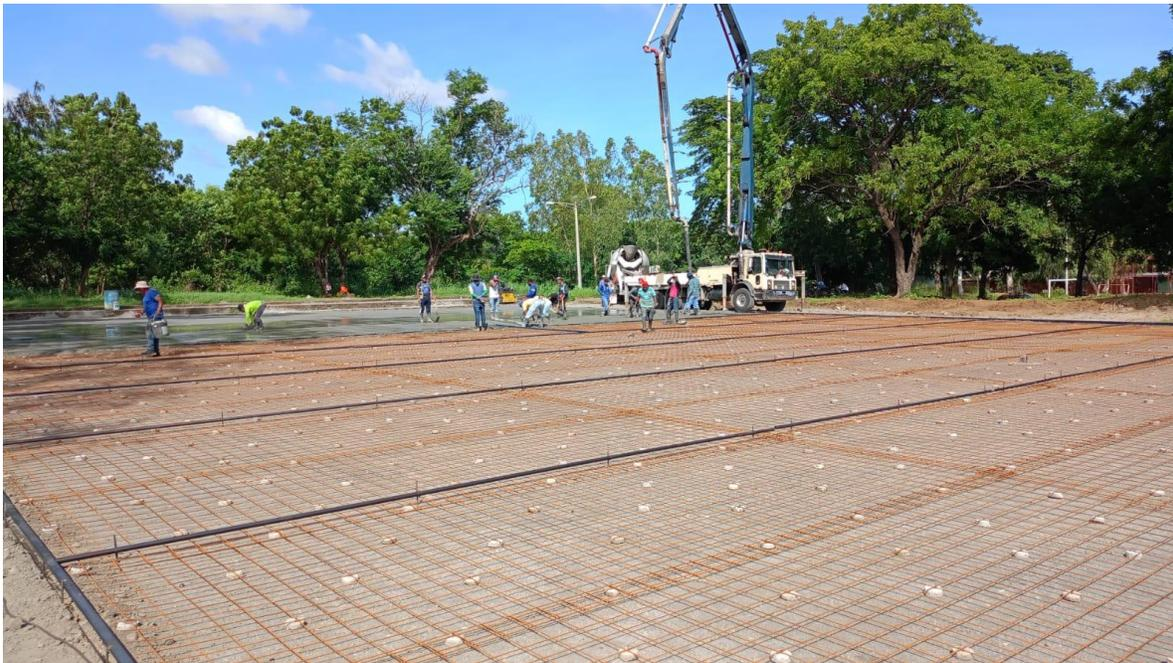
**Nota:** proceso final de colocación de malla electro soldada sobre los separadores, para proceder al llenado de concreto. (Fuente: ODI). (2023).
