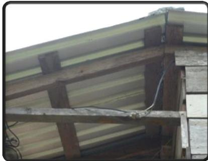
Fig.Nº.54. Mal ejecución de las instalaciones eléctricas.
