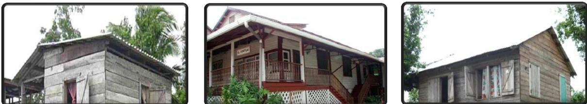
Fig. # 18, 19, 20: típica utilización de cubierta de zinc a dos aguas en las viviendas de la RAAN, Puerto Cabezas.
