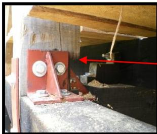
Fig. # 40: unión columna-viga
