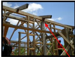
Fig. # 38: unión columna con estructura de techo
