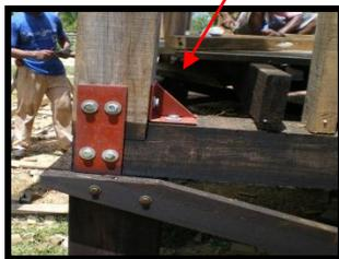
Fig. # 42: implementación de platinas en unión cemento-columna
